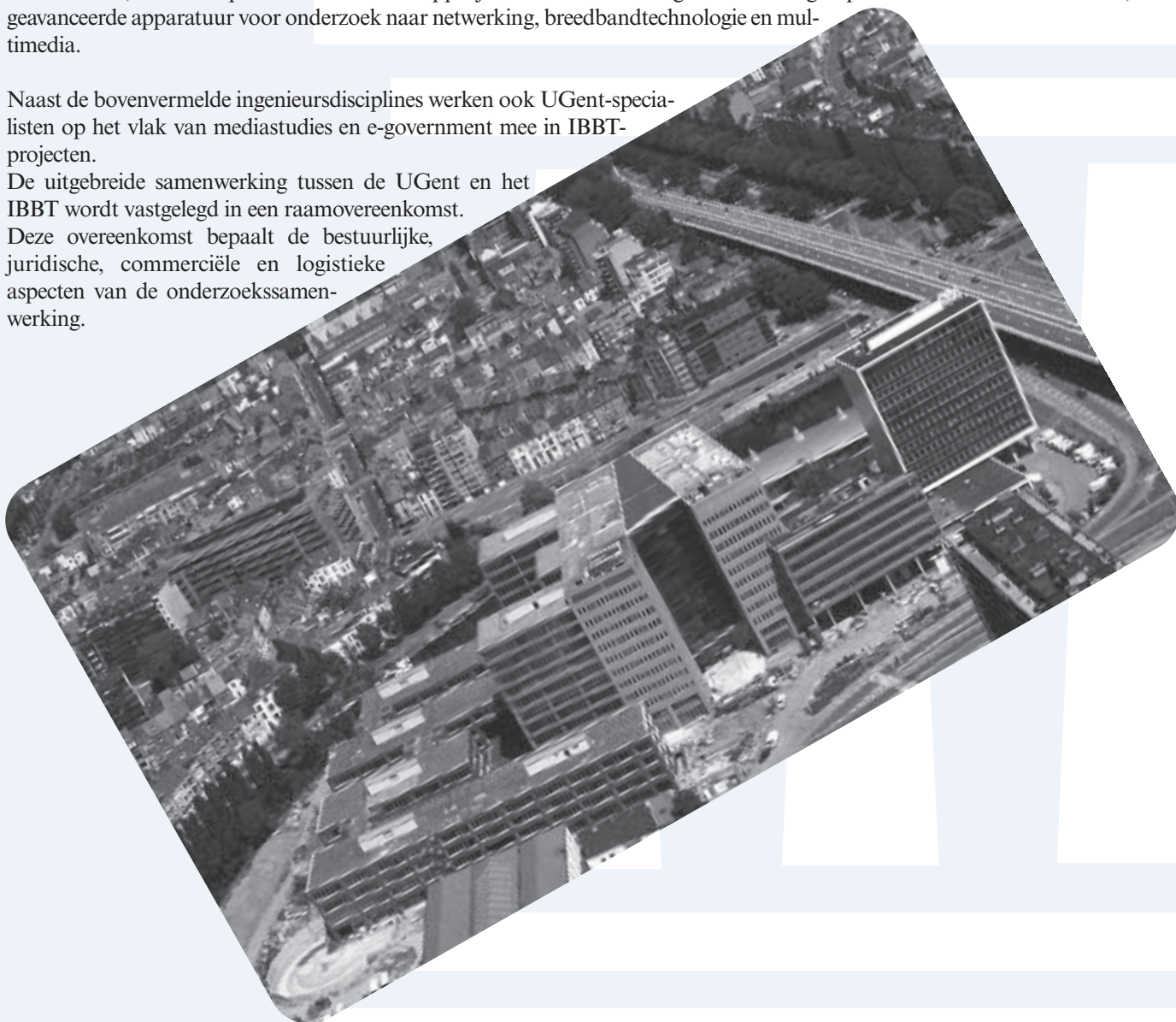
foto: gebouw Zuiderpoort
