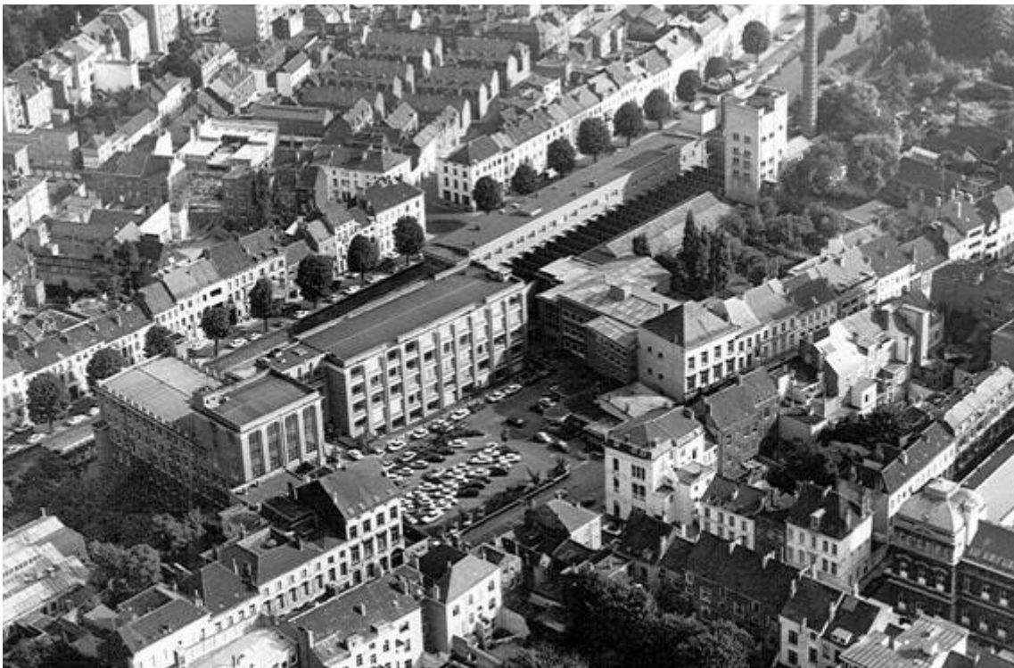
Luchtfoto van de Sint-Pietersnieuwstraat met het Technicum en een deel van het Plateaugebouw (Collectie Universiteitsarchief Gent - foto I.M.P.F.)
